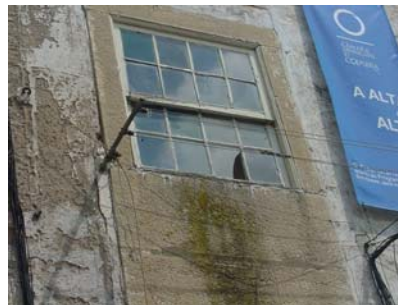
Estado da caixilharia e vidros
