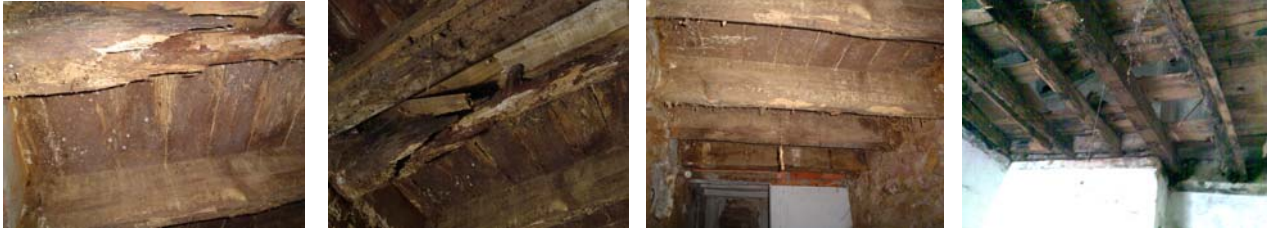
Estado das estruturas em madeira
