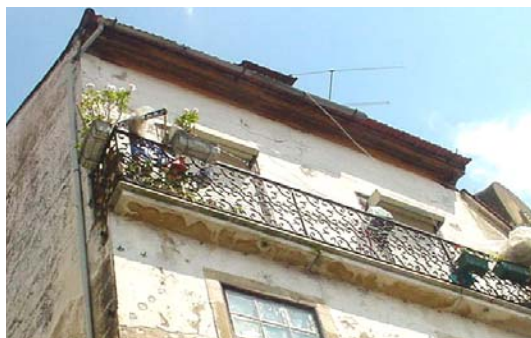
Caleiras e tubos de queda
