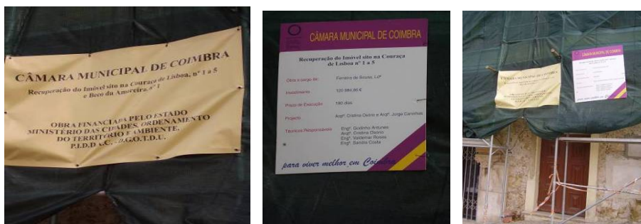
Placas identificativas da obra
