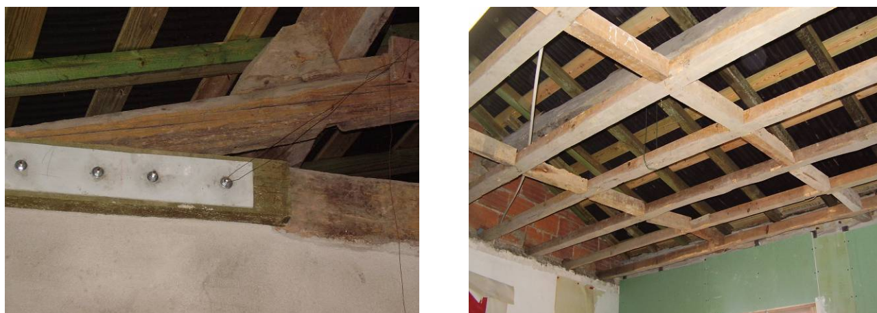
Estrutura de suporte da cobertura
