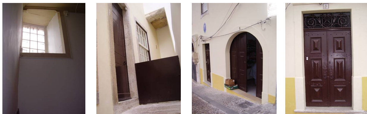
Vãos de portas e janelas recuperados
