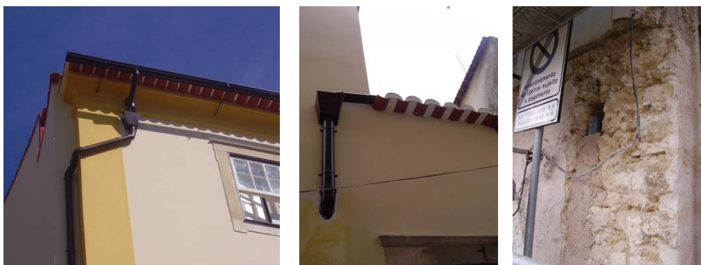
Sistema de drenagem
