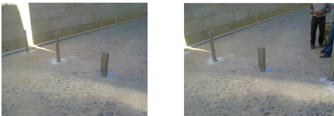
Pormenores da entrada da zona de controlo de acesso condicionado, com pino retráctil e pinos fixos
