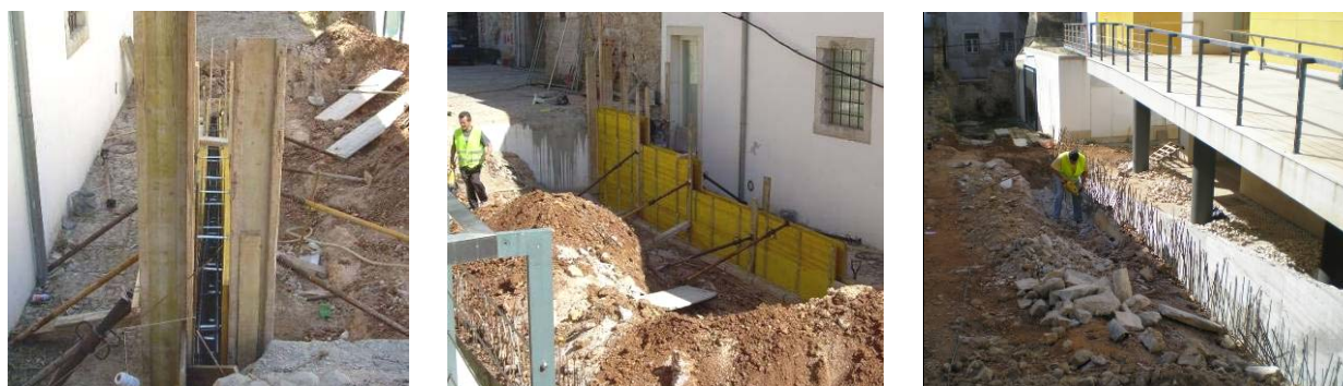
Execução do muro lateral das escadas/rampa a nascente do teatro
