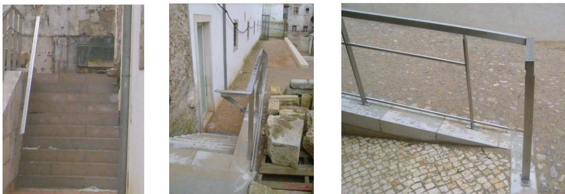
Pormenor das escadas laterais à rampa e da guarda em inox
