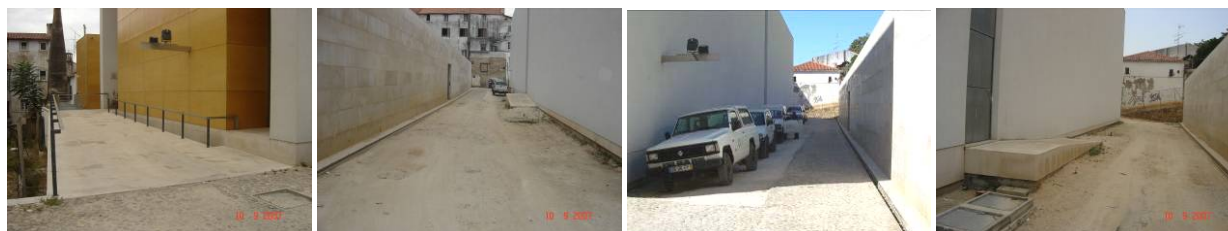
Entrada principal do edifício do Teatro da Cerca de São Bernardo e Rua a norte do mesmo - Execução de pavimentação apenas numa área limitada, encontrando-se a restante parte em terra batida
