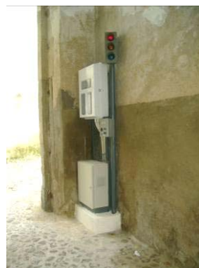
Quadro de geral, compressor e semaforização
