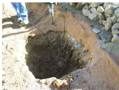
Escavação para abertura de caixa
