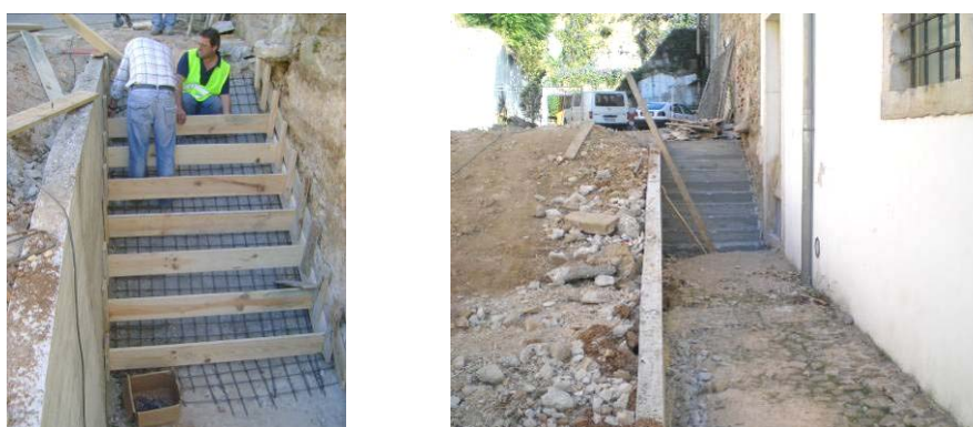
Execução escadas a nascente do teatro
