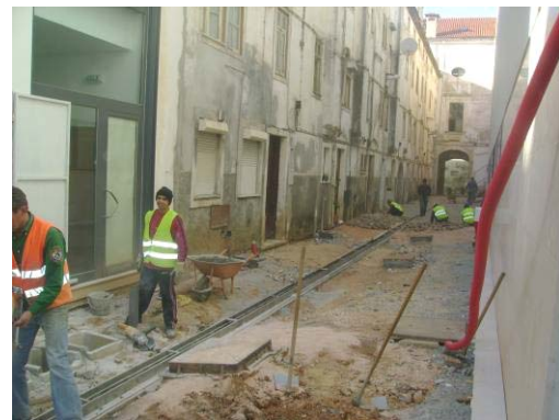
Execução da caleira central e subida/rebaixamentos de caixas na Rua a Poente do Teatro
