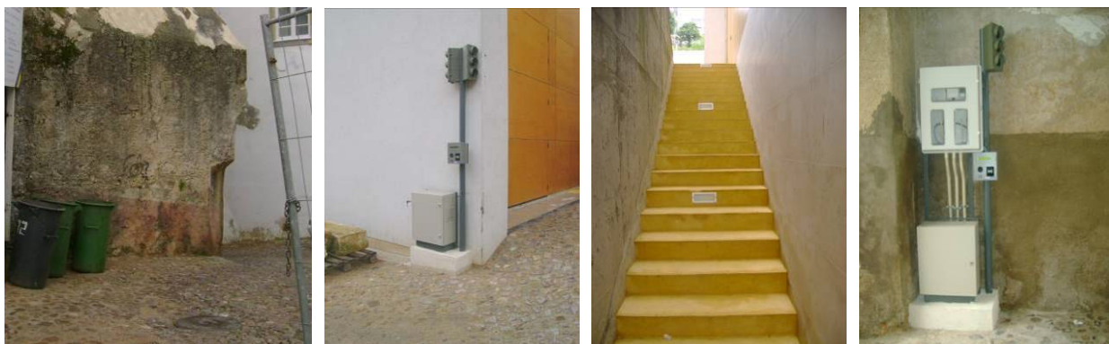
Pavimentação da entrada a norte do Teatro
