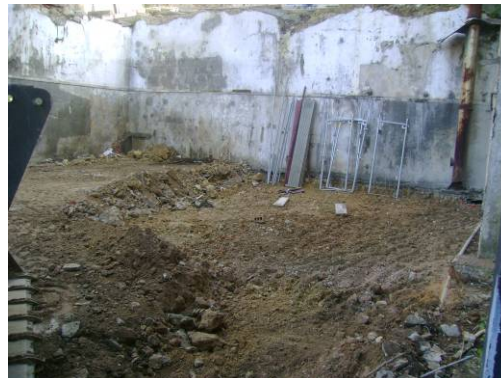
Trabalhos de escavação para abertura de caixa na área contígua ao antigo Colégio das Artes
