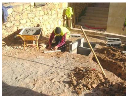
Execução de caixas de visita em alvenaria de tijolo
