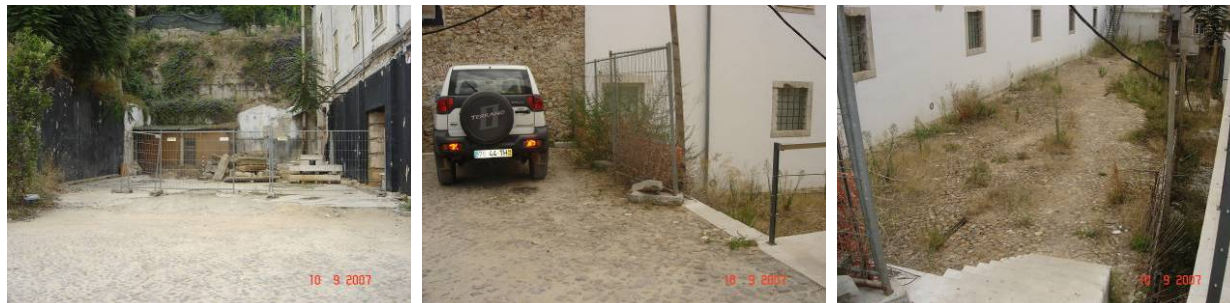
Área contígua ao antigo Colégio das Artes - Vestígios de antigo estaleiro referente à empreitada de construção do Teatro; detritos da anterior empreitada e infestação de plantas herbáceas e " Ailanthus altissima ", vulgo espanta-lobos
