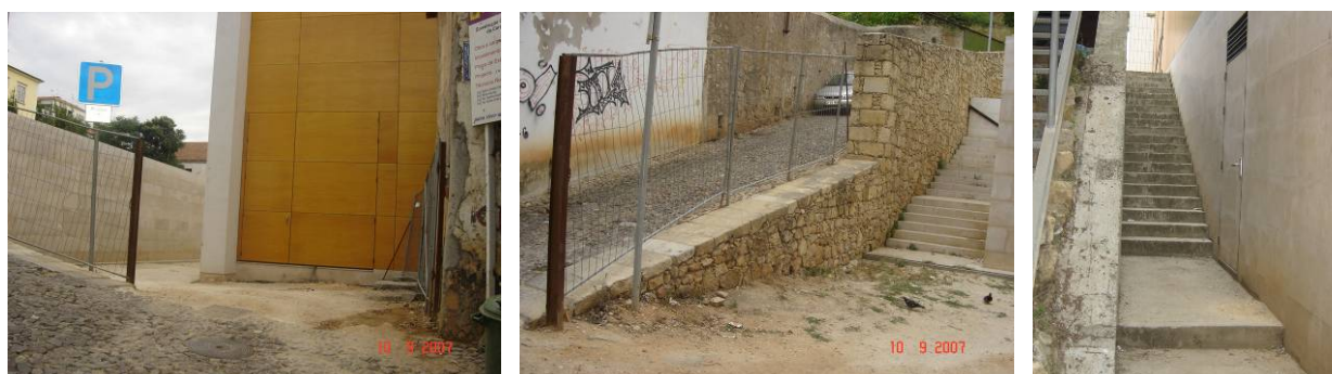
Alçado posterior do edifício do Teatro - Acesso sinuoso, falta de pavimentação e escadas
