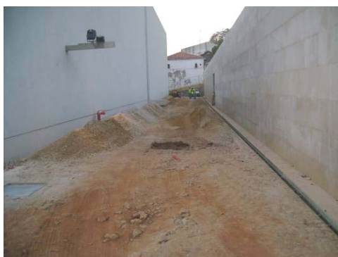
Trabalhos de preparação (camadas de base e sub-base) para posterior pavimentação na Rua a Nascente do Teatro
