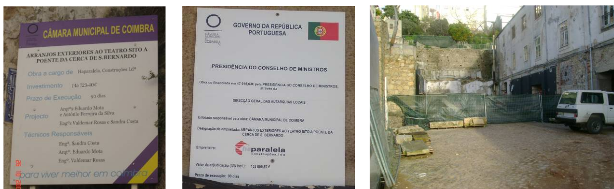
Placas identificativas da obra e identificação de estaleiro
