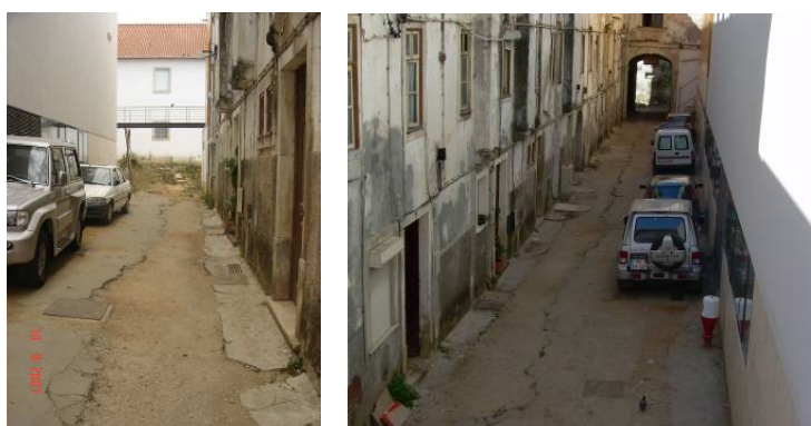
Rua a poente do edifício do Teatro - Rua em mau estado de conservação
