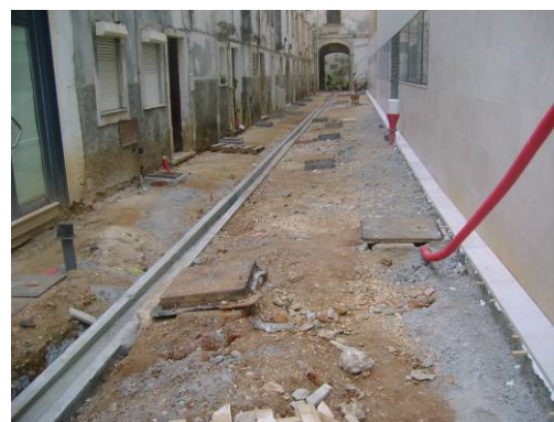
Execução da caleira central e subida/rebaixamentos de caixas na Rua a Poente do Teatro
