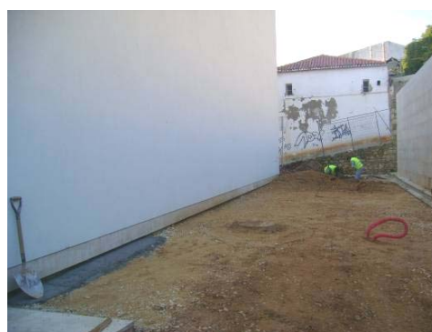
Trabalhos de preparação (camadas de base e sub-base) para posterior pavimentação na Rua a Nascente do Teatro
