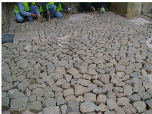
Pormenor de execução de calçada de seixo
