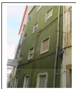
Antes da intervenção
