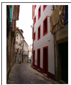
Depois da intervenção
