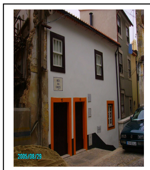
Depois da intervenção
