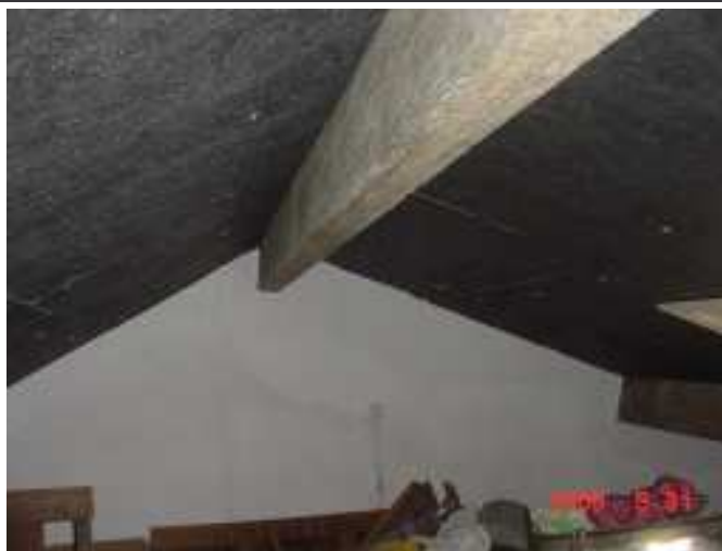
Isolamento Térmico (Lã de Rocha, em placas, 70kg/m 3 )
