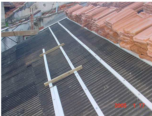
Impermeabilização (sub-telha e telha Marselha)
