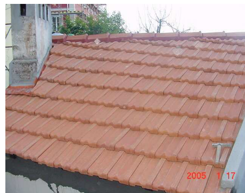
Impermeabilização (sub-telha e telha Marselha)
