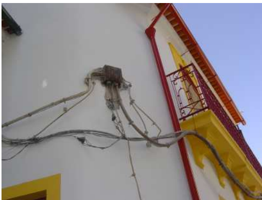
Sistema de Drenagem das águas pluviais
