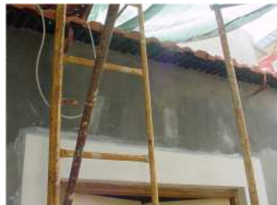
Reboco das paredes exteriores
