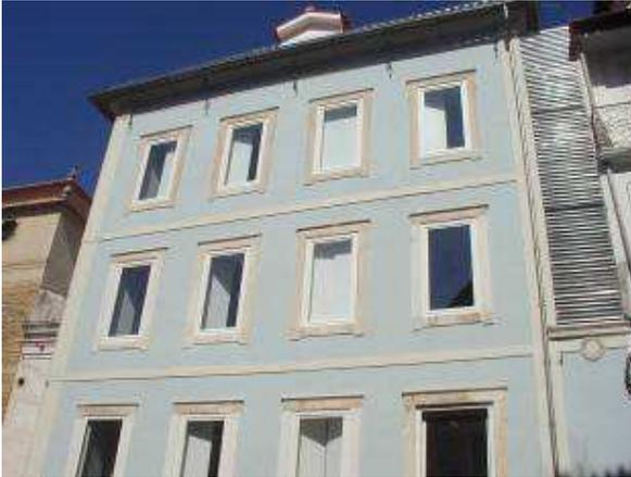
Para os vãos a solução consistiu na limpeza das cantarias e a substituição das janelas por caixilhos de madeira lacada a branco de folha única e portada interior de madeira à mesma cor.
