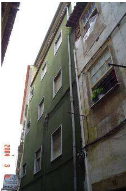
Antes da intervenção
