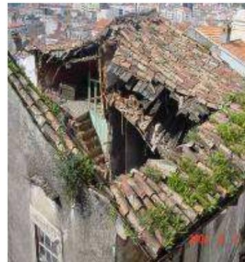
Tendo em conta o estado do imóvel, para elaborar o projecto de reconstrução, foi necessário proceder a obras de contenção das fachadas confinantes com os arruamentos, limpeza dos entulhos acumulados no interior e ainda a demolição de uma área residual.
