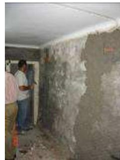
Picagem e execução de reboco armado (com rede de galinheiro)
