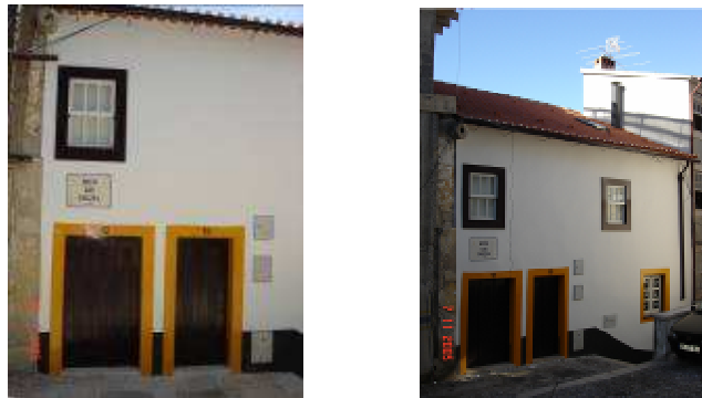
Vista dos acabamentos e pinturas, depois da intervenção
