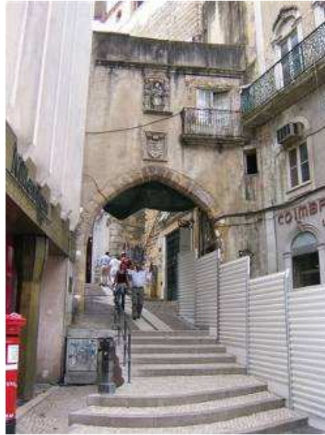
Fachada Poente do Arco Pequeno de Almedina - antes da intervenção.
