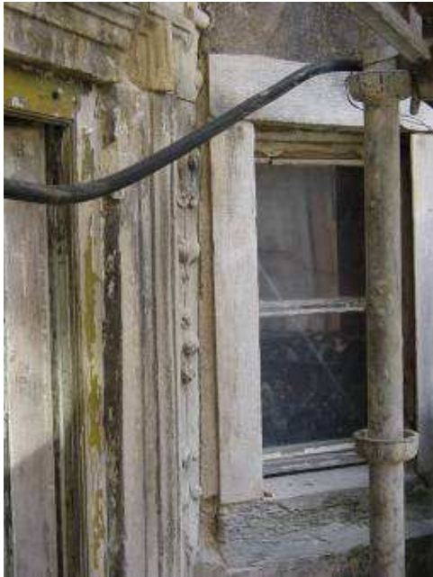
Janela e pano de alvenaria a demolir e reconstituir
