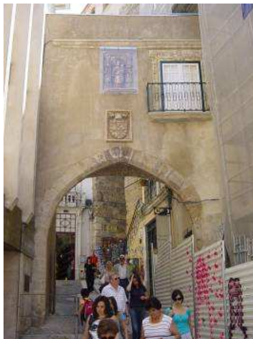
Fachada Poente após intervenção
