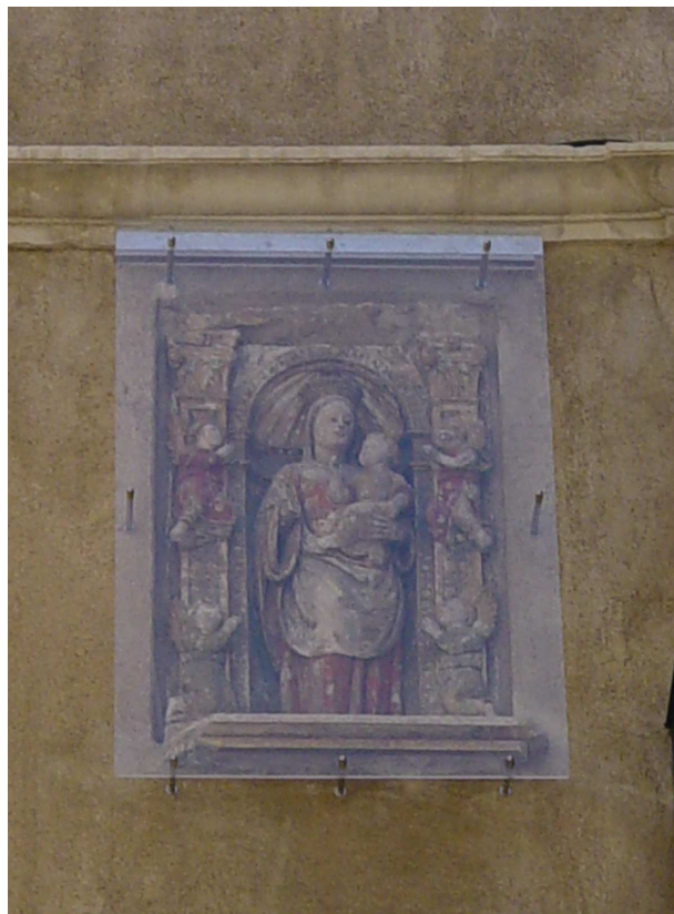
Pormenor - protecção física aplicada, com ventilação inferior e lateral
