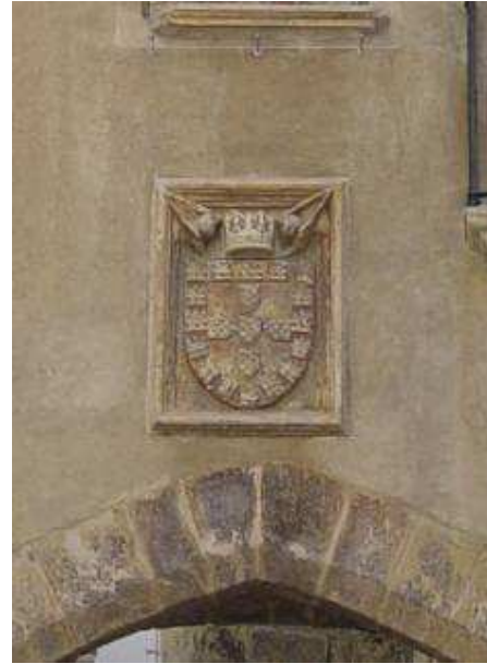
Escudo após limpeza e fixação de policromia
