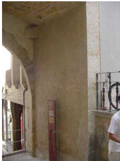
Aspecto final da parede lateral Norte
