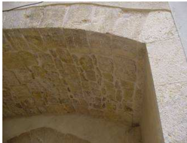
Aspecto geral do intradorso do Arco após tratamento de juntas e superfícies
