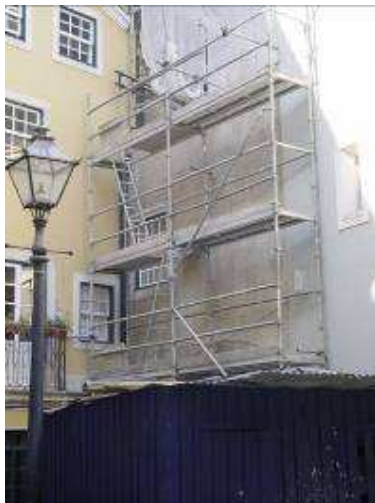
Desmontagem de andaimes e plataformas de acesso
