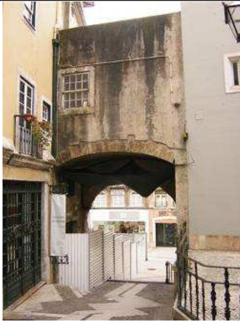
Fachada Nascente do Arco Pequeno de Alameda - antes da intervenção
