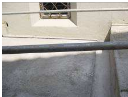
Fase de execução de sistema de impermeabilização da cobertura - sistema de penetração osmótica, camada de forma em betão leve, betonilha e revestimento em chapa de zinco
