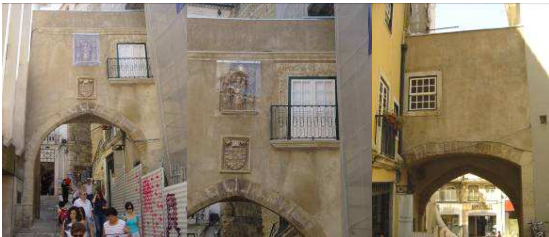
Fachada Poente e Nascente do Arco Pequeno de Almedina posteriormente à intervenção
