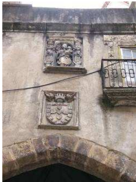
Fachada Poente - antes da intervenção
