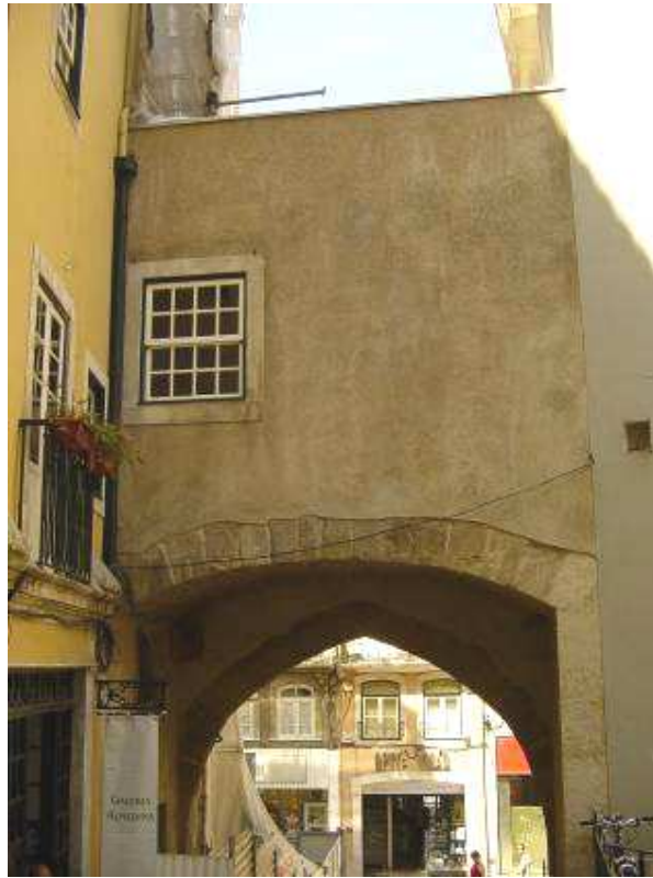
Fachada Nascente após intervenção
