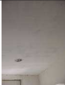
Tecto falso aplicado - divisão interior
