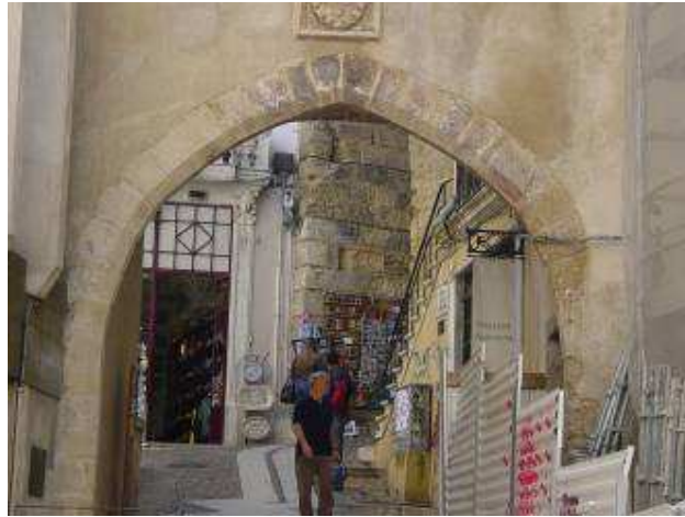
Arco - fachada Poente
