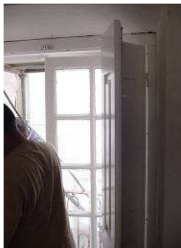
Montagem de carpintarias - janela de sacada no alçado Poente
