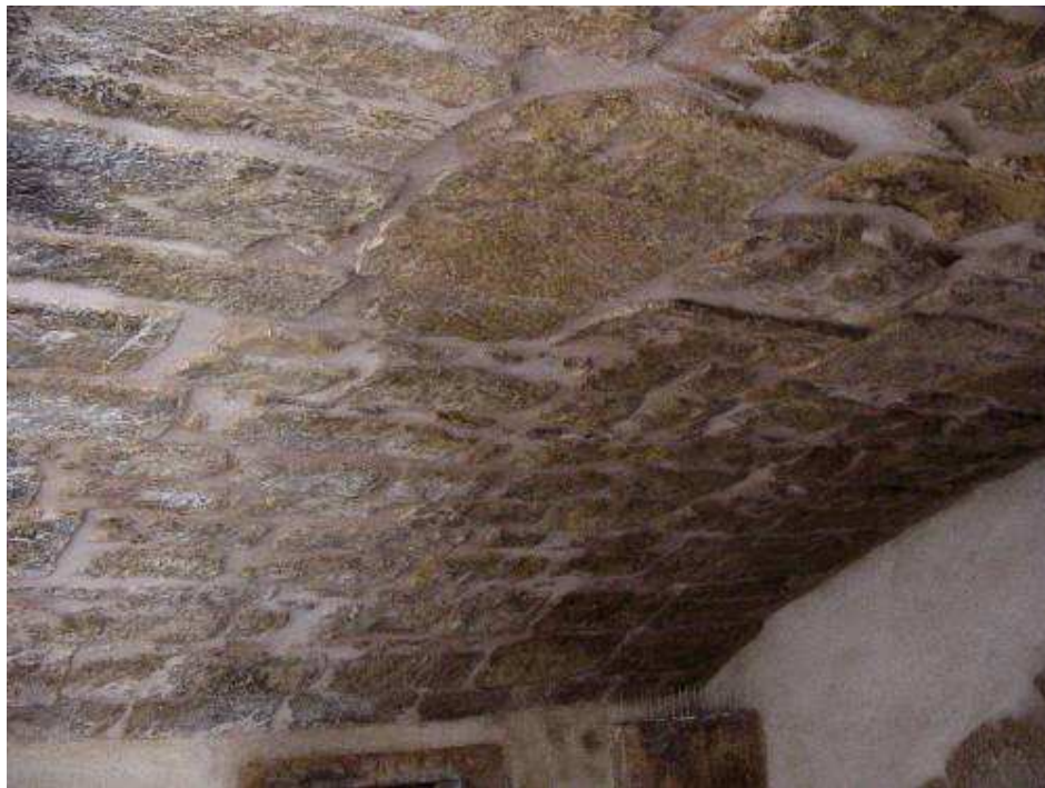
Aspecto final do intradorso do Arco após remoção do material de junta, seu refechamento e consolidação; estucagem e micro-estucagem selectiva em elementos pétreos
