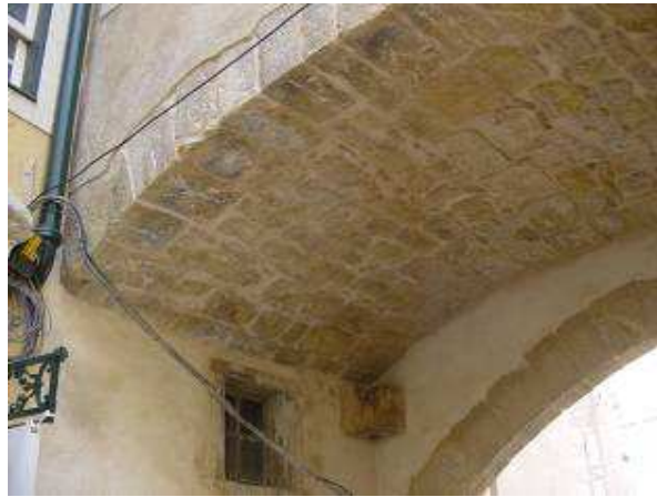
Aspecto geral do intradorso do Arco após tratamento de juntas e superfícies
